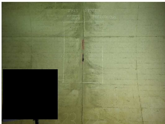
写真4-26 【損傷】浮き
