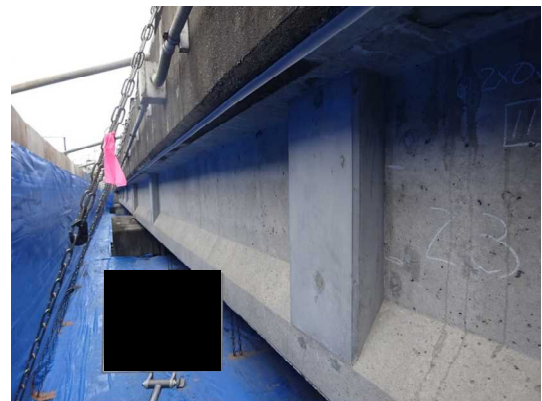
写真4-15 【対策】 定着部の打換え
