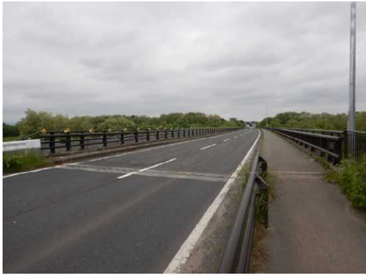
写真4-1 【全景】金ヶ崎大橋
