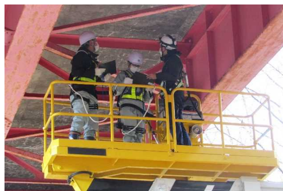
写真5-4 高校生との協働による橋梁点検
