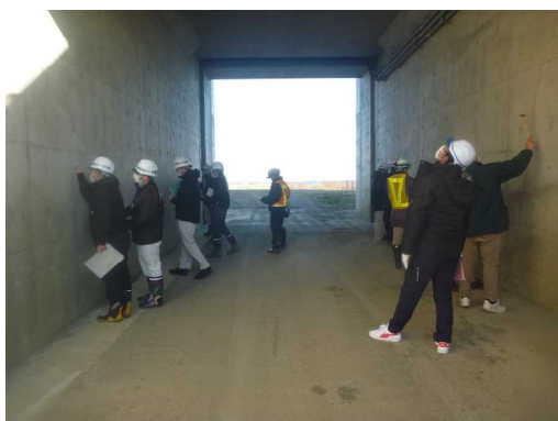
写真5-3 溝橋点検の講習会
