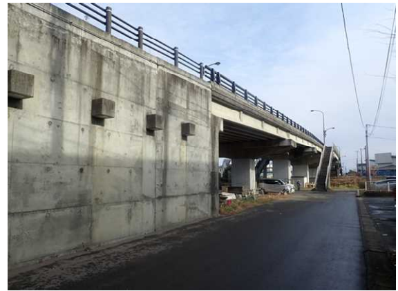
写真4-13 【全景】新中の橋
