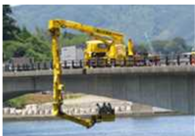
写真2-1 橋梁点検状況
