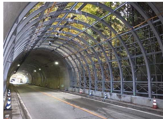
写真4-30 【対策】主梁の金属溶射
