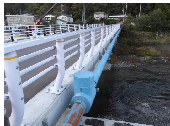
写真4-18 【対策】地覆打換え
