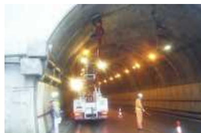
写真2-2 トンネル点検状況
