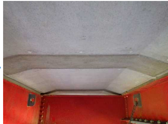
写真4-9 【対策】床版取替え
