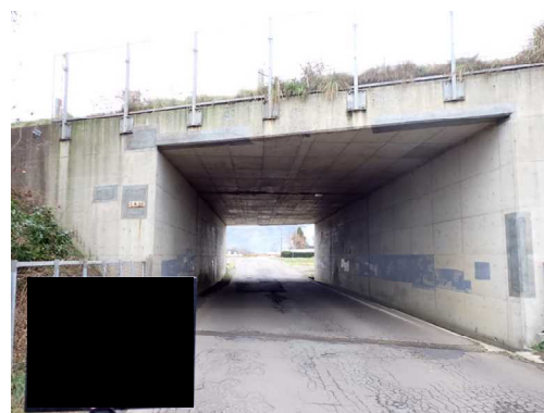
写真4-21 【対策】 断面修復および表面被覆工
