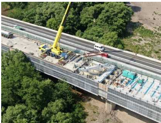
写真4-5 【対策】床版取替え状況
