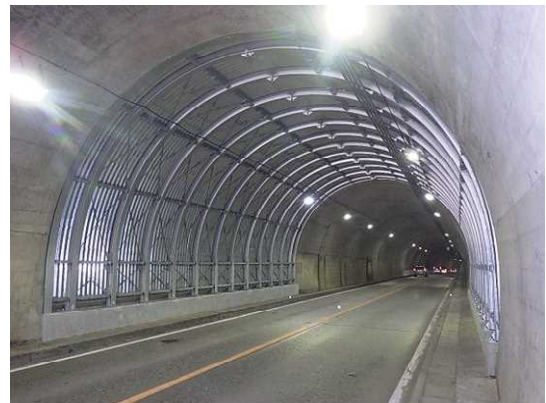
写真4-28 【全景】柏木スノーシェルター
