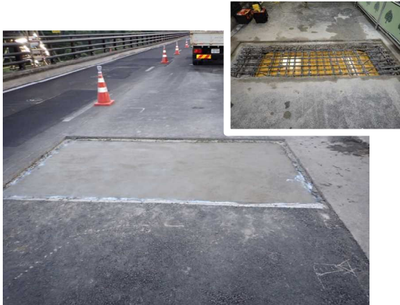
写真4-3 【対策】床版の打換え
