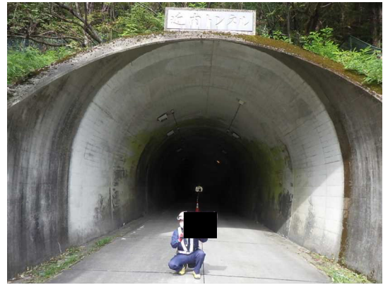
写真4-25 【全景】近内トンネル
