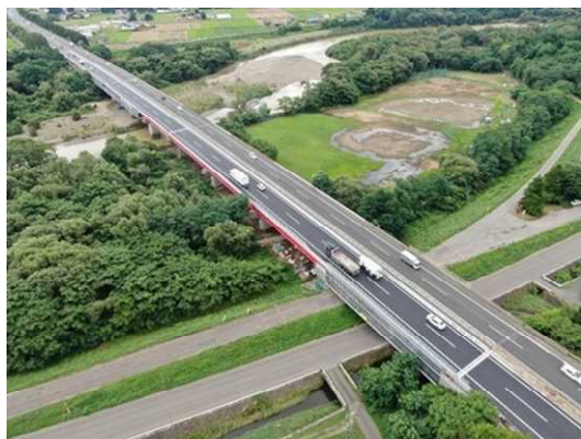
写真4-6 【完成後】床版取替え後
