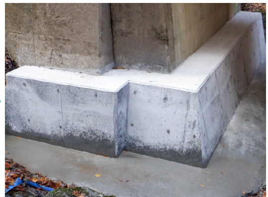
写真4-12 【対策】橋台の根継工
